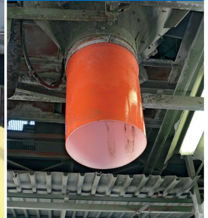
der Elastizität, jedoch verbunden mit dem Nachteil der Abknickgefahr des Schlauches bei nicht zentrischer Übergabeposition des Fahrmischer. Zusätzlich besteht im Abknickfall die Neigung zum Platzen des Schlauches auf Grund unzureichender Nahtverbindungen.
